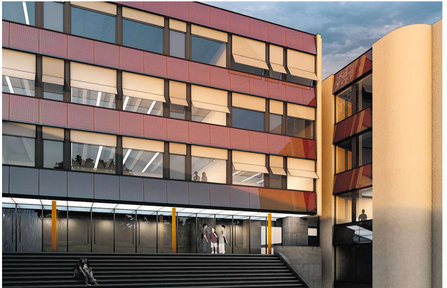
Moderne und Minergie: Mit Blech statt Eternit und mit sehr viel mehr Isolation bekommt die Kantonsschule Glarus ihr neues Gesicht. Bild Soliman Zurkirchen Architekten
