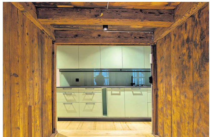
Die Bohlenständerbauweise vom ganzen Südhaus ist sehr zentral.
