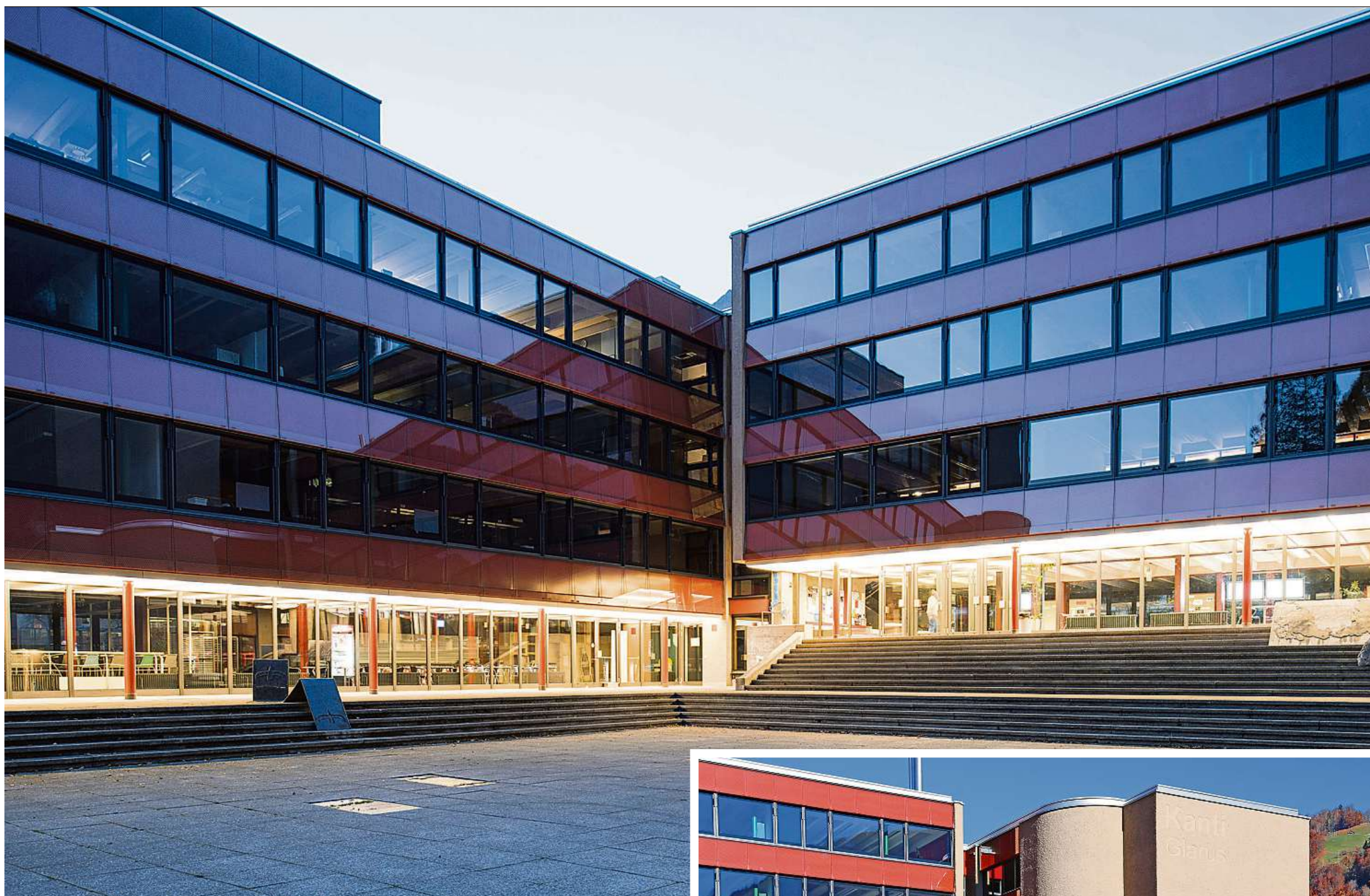
Im Eingangs- und Mensabereich ist der gedeckte Aussenraum mit einer neuen Lichtdecke ausgestattet worden.
